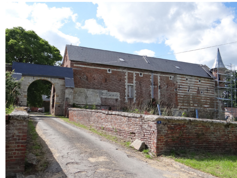
Fig.125. Château de Beaufort-en-Santerre
