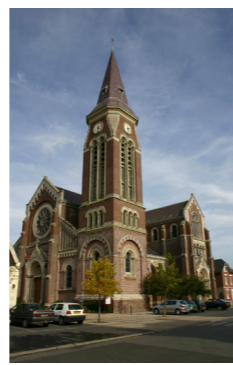
Fig.97. Eglise de Rosières en Santerre (non protégée)
